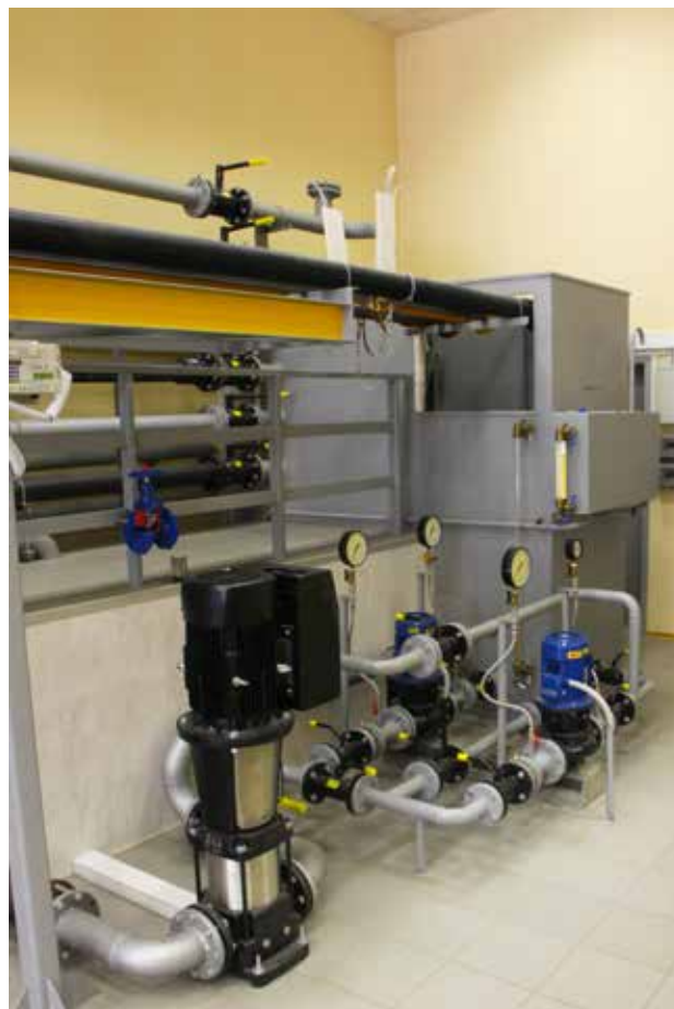
Лабораторная насосная установка GRUNDFOS
