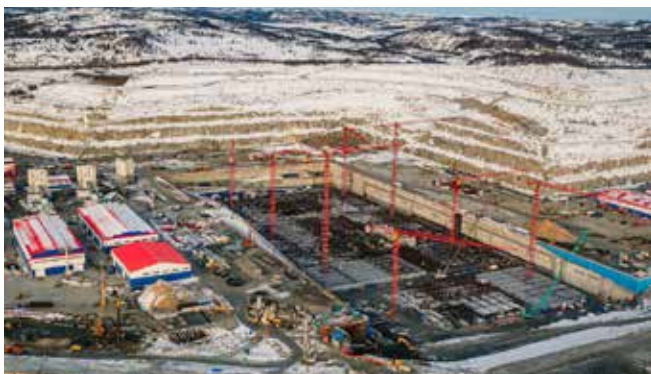
Центр строительства крупнотоннажных морских сооружений. Комплекс для изготовления оснований гравитационного типа и интеграции модулей верхних строений
