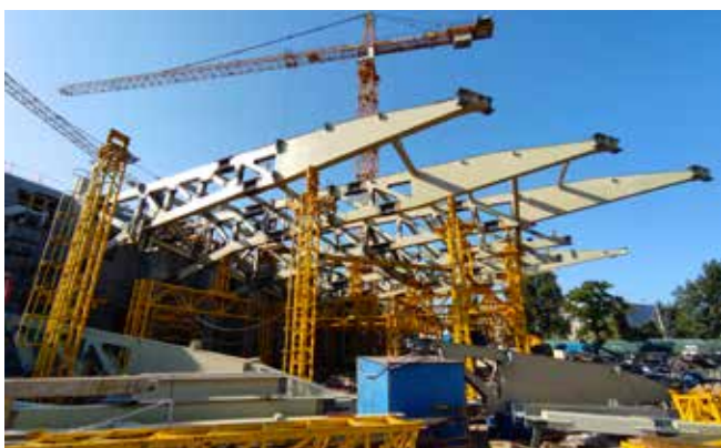
г. Москва, Проспект Мира, вл. 119, Павильон Атомной энергии
