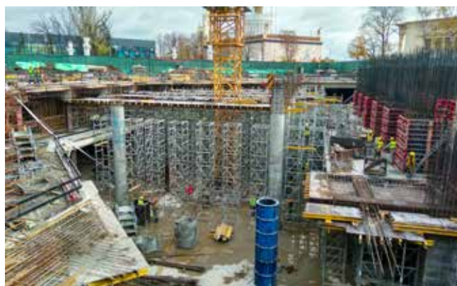
г. Москва, Проспект Мира, вл. 119, Павильон Атомной энергии
