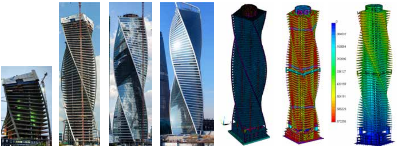
Расчетные исследования НДС, прочности и устойчивости несущих конструкций башни «Эволюция» ММДЦ «Москва-Сити» с учетом фактического положения ж/б конструкций и генетической нелинейности
